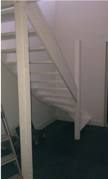
De trap naar de zolder is zojuist geïnstalleerd
