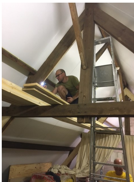
Zolderbalken versterken voor het aanbrengen van de zonnepanelen.
