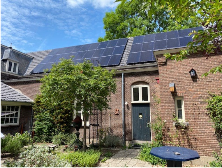
17 juni 2020: de zonnepanelen zijn geplaatst
