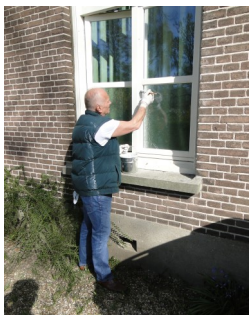
John verft de buiten kozijnen.
